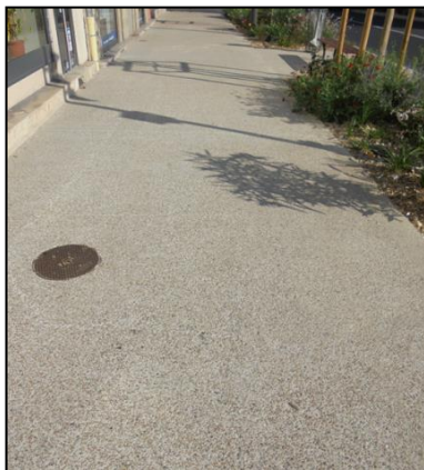
Aménagement Béton désactivé Avenue de Paris
