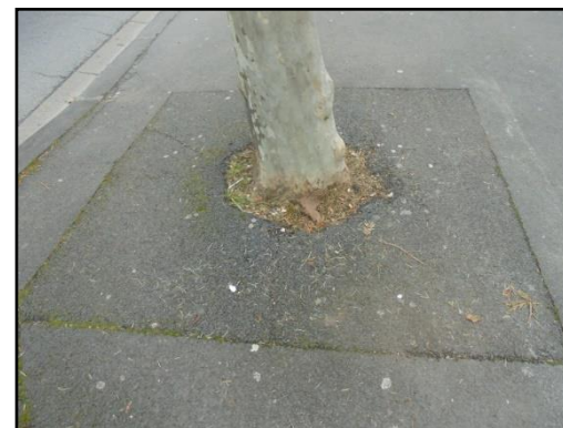
Enrobé drainant au pied des arbres Boulevard PUYBLANC
