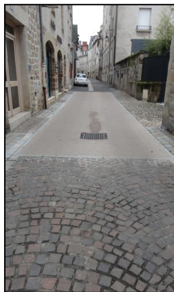
1 Mise à niveau trottoir et chaussée
