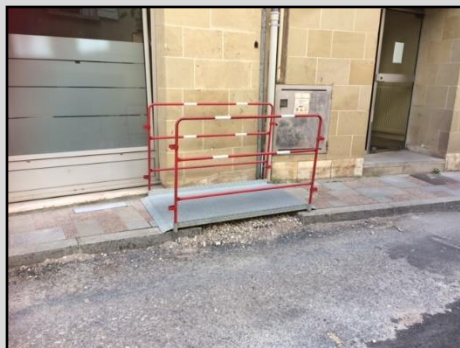
Mise en place d'un « pont piéton » Rue Charles Teyssier
