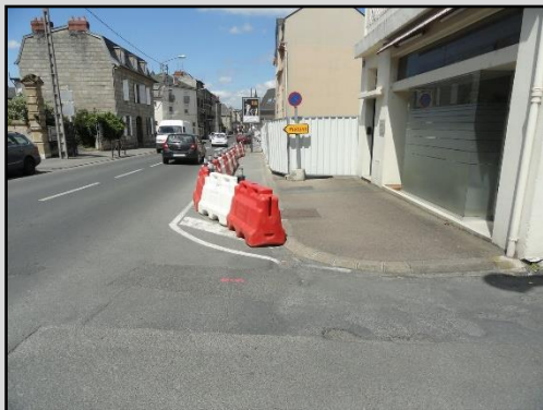
Signalisation de chantier Bd Edouard Herriot
