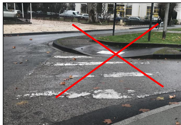
Traversée au niveau de l'entrée du parking souterrain Thiers
