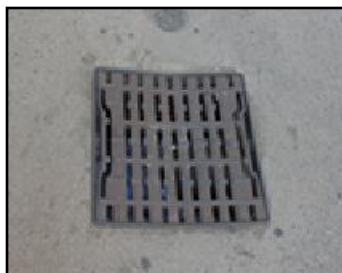
Aménagement de grille Rue de Corrèze
