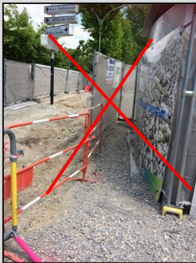
Accès ascenseur parking Thiers Chantier Halle Alimentaire
