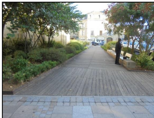
Mise en place de bandes antidérapantes sur le bois Place Charles De Gaulles
