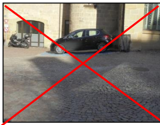
Place PMR – Place jean Marie DAUZIER Pente et revêtement pavés disjoints à proscrire
