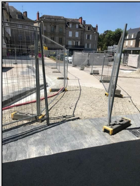
Chantier Halle Gaillarde Place De Lattre de Tassigny
