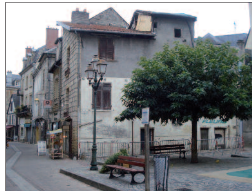
Immeuble insalubre avant la déconstruction réalisée en 2017.
