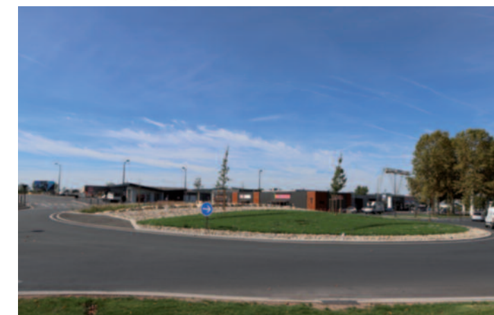
Le giratoire du Teinchurier mis en service en 2016.
