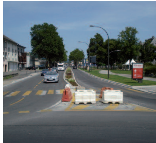
L'avenue en travaux au niveau du rond point de la Fraternité (2017).
