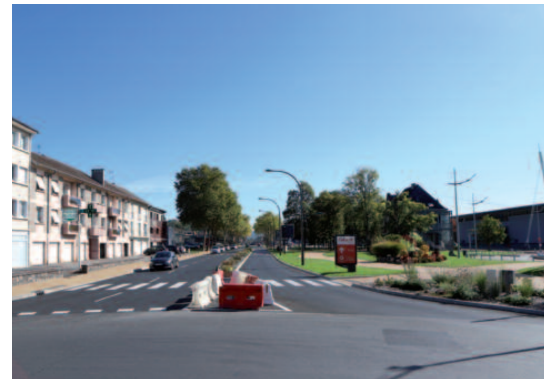
Le chantier a rempli ses objectifs de développement durable (réutilisation de matériaux, bus à haut niveau de service...).
