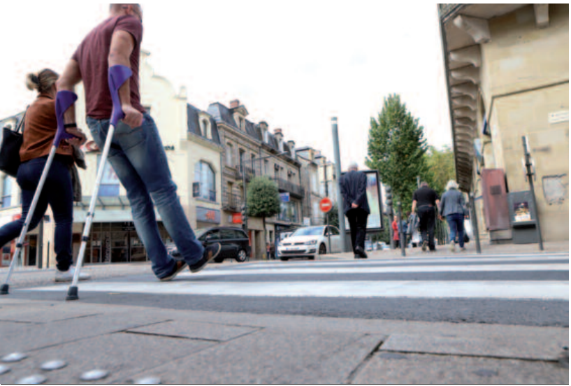
Aménagement des trottoirs au croisement de l'avenue de Paris et boulevard Anatole France.
